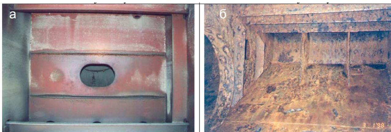
Рисунок 20 - Фотографии балластных танков двух судов одинакового возраста 13 лет: а - покрытие нанесено с соблюдением стандарта, б – с нарушением технологии
